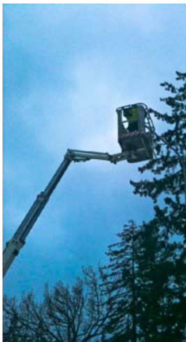
Installation av SunFIRE7 LED-armatur på parkeringen vid Bilprovningen i Nacka.
